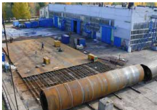
Рис. 1. Процесс изготовления РВС
