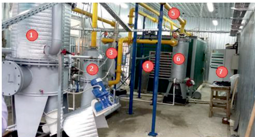
Рис. 2. Комплекс газификации производства ООО «НПП «Синтез»: 1 – реактор газификации, 2 – теплообменник стабилизатор газа, 3 – рабочий сепаратор, 4 – газопоршневая электростанция в контейнере, 5 – трубопроводы, 6 – резервный сепаратор, 7 – шкаф управления
