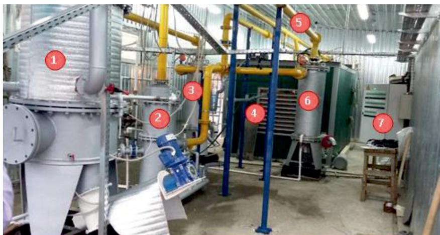
Рис. 2. Комплекс газификации производства ООО «НПП «Синтез»: 1 – реактор газификации, 2 – теплообменник стабилизатор газа, 3 – рабочий сепаратор, 4 – газопоршневая электростанция в контейнере, 5 – трубопроводы, 6 – резервный сепаратор, 7 – шкаф управления
