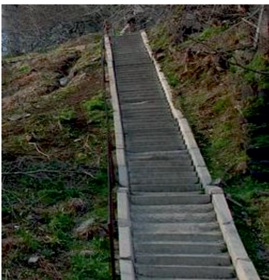
Рис. 3. Вид лестницы, ведущей на верхнюю станцию фуникулёра
