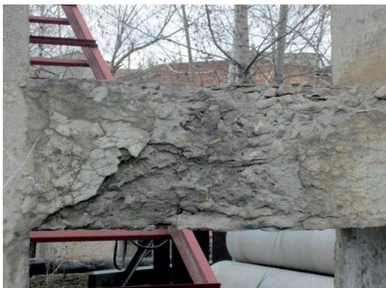
Рис. 1. Растрескивание перемычки колонны
