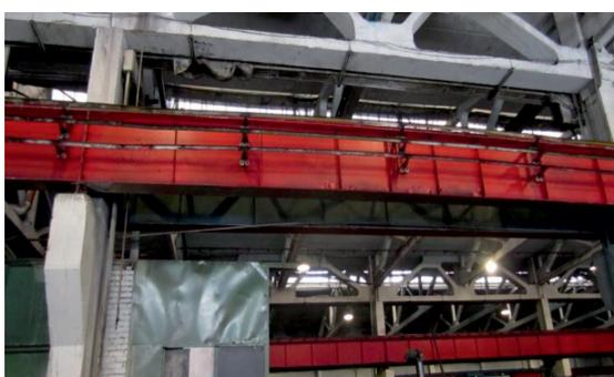
Рис. 3. Металлическая подкрановая балка со следами коррозии
