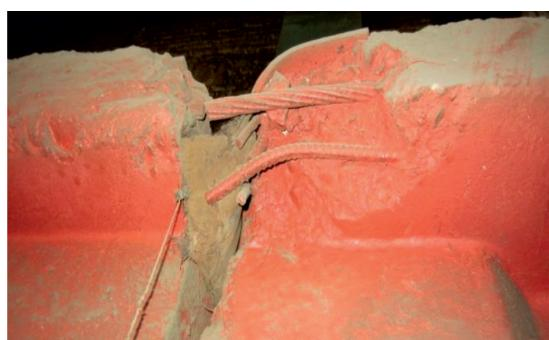
Рис. 4. Железобетонная подкрановая балка с оголённой рабочей арматурой
