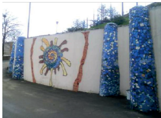
Рис. 5. Использование экспериментальных технологий при декорировании подпорных стен на территории кампуса ВГУЭС
