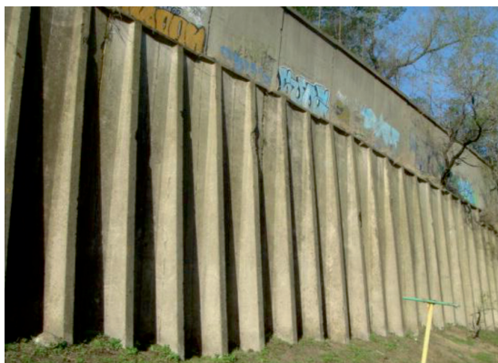
Рис. 1. Индустриальные конструкции городских подпорных стен во Владивостоке
