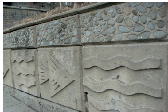
Рис. 3. Облицовка подпорных стен плитами с активной декоративной пластикой
