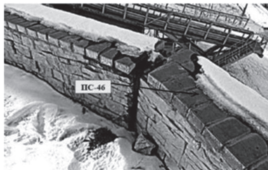
Рис. 1. Дефекты подпорной стенки
