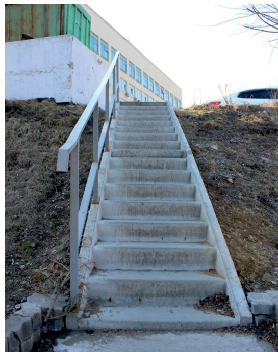
Рис. 2. Лестница по ул. Гоголя, 41, территория ВГУЭС (г. Владивосток). Разная высота и глубина ступеней: 40х630, 70х630 – 4 ступени, 70х530, 70х440 – 2 ступени, 70х550 – 7 ступеней, 70х880, 70х190, 70х270. Лестница выполнена непрофессионально. Подниматься и спускаться по ней затруднительно
