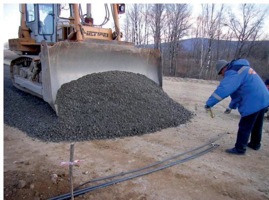
Рис. 5. Установка месдоз
