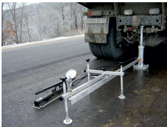
Рис. 4. Испытания дорожной одежды штампом
