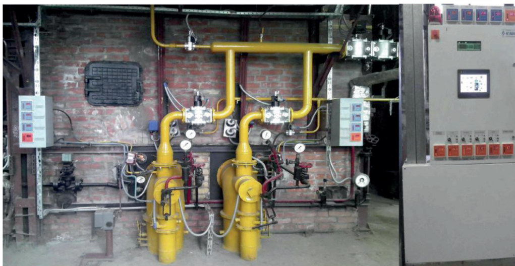
Рис. 3. Общий вид фронта котла ДКВР-10-13 с горелками ГМГ-4М, оборудованного системой «Факел-2010» (справа – щит управления системы с монитором)
