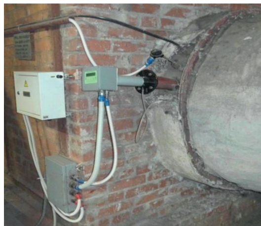
Рис. 5. Интеллектуальные анализаторы качества горения в составе системы «Факел-2010»: КАКГ в газоходе за котлом (слева) и ИАКГ в газоходе за экономайзером (справа)
