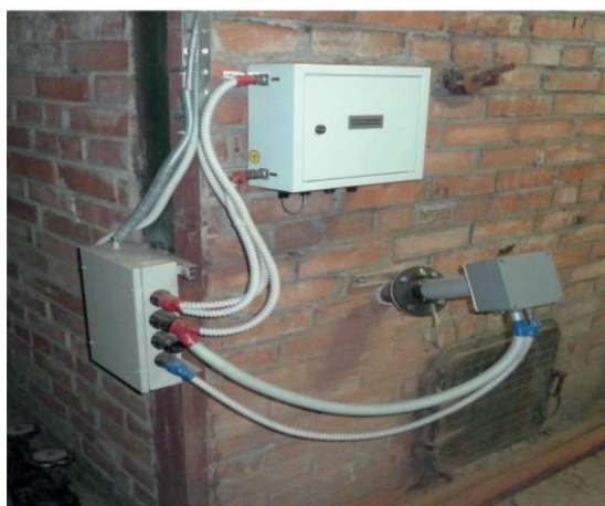
Рис. 5. Интеллектуальные анализаторы качества горения в составе системы «Факел-2010»: КАКГ в газоходе за котлом (слева) и ИАКГ в газоходе за экономайзером (справа)
