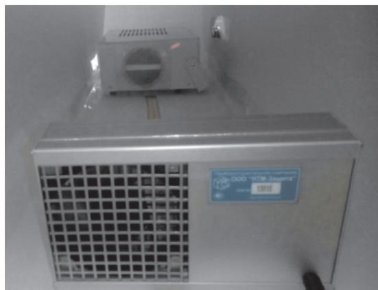
Рис. 1. Счётчик и генератор аэроионов внутри воздуховода
