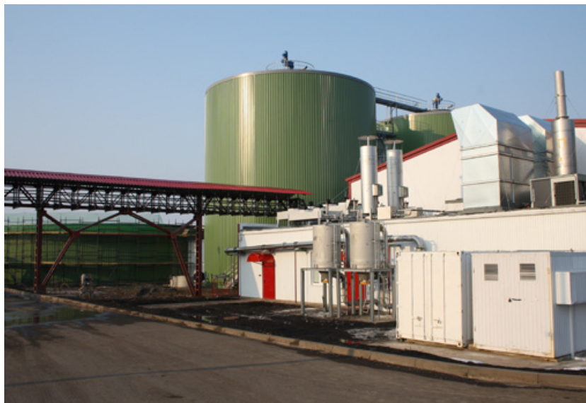
Рис.1 Биогазовая станция. Лучковский сельский округ
