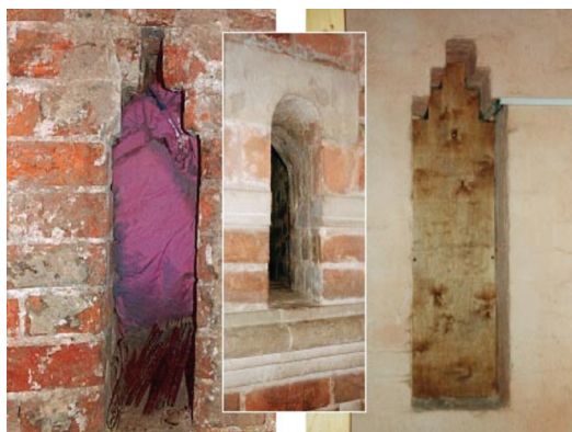
Рис. 2 Вентиляционные отверстия в подклете
