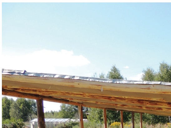
Рис. 1. Общий вид испытательной площадки. Размеры площадки в плане 5x9 м, заглубление 0,8 м. Вертикальные стенки площадки усилены опалубкой из досок дюймовой толщины. Для защиты участка от атмосферных осадков выполнен навес из деревянных вертикальных стоек, горизонтальных балок с обрешеткой и стальным оцинкованным настилом с уклоном кровли 0,03
